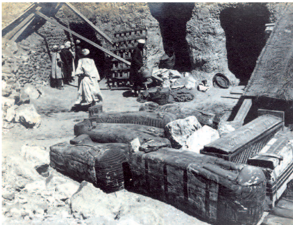
Imagen de excavación en Tebas
